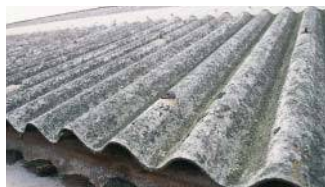
Toiture en amiante-ciment
