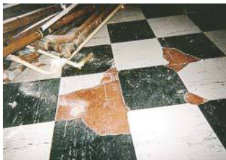
Dalles de sol
