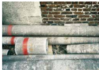
Canalisation en amiante-ciment
