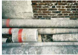
Canalisation en amiante-ciment
