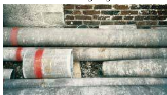
Canalisation en amiante-ciment
