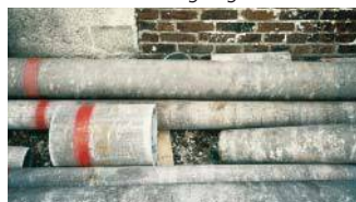
Canalisation en amiante-ciment
