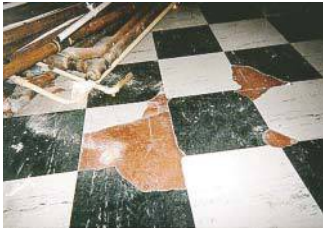
Dalles de sol
